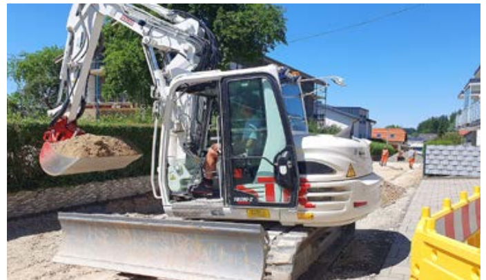
Die Siedlungsstraße im Kreuzfeld wird heuer saniert.
