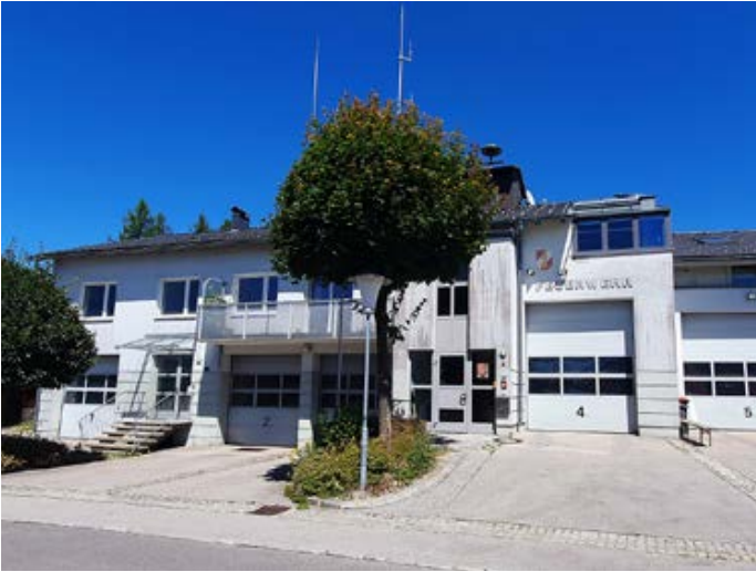
Das Hellmonsödter Feuerwehr-Zeughaus ist sanierungsbedürftig und entspricht nicht mehr den heutigen Anforderungen.
